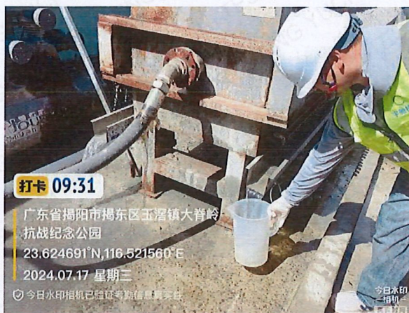
施工 1 标 3#支洞隧道洞口排水
