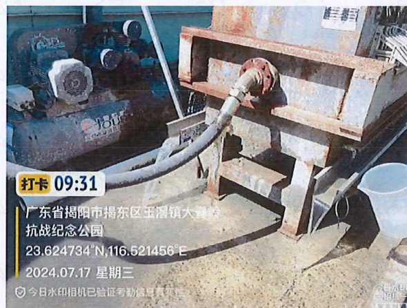
施工 1 标 3#支洞隧道洞口排水
